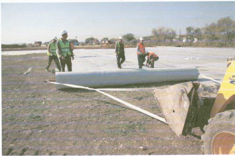
Закриване на Първо окислително езеро
